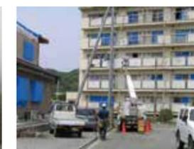
2012年5月に発生した竜巻で被害を受けた、茨城県つくば市内の電柱26本や通信ケーブルなどの設備137カ所の復旧工事を行いました。
