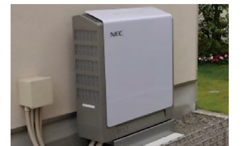
戸建て向け蓄電システム
