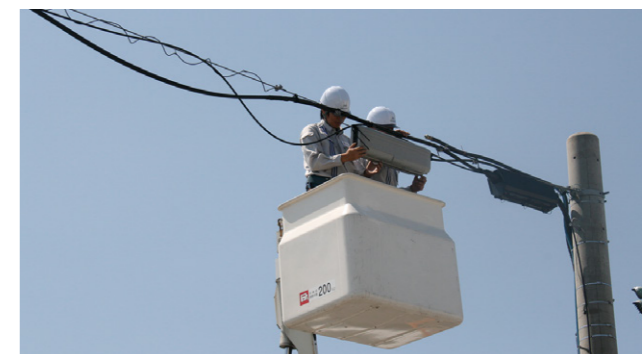
光ファイバケーブルの接続作業
