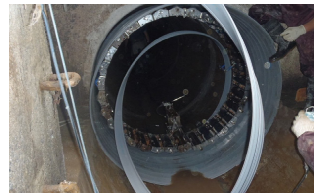
老朽下水管の更生（SPR工法）
