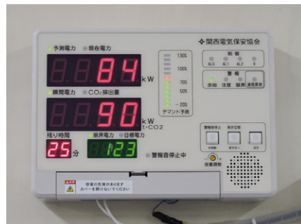
デマンド監視装置
