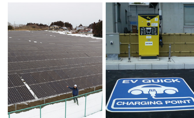
太陽光発電設備
