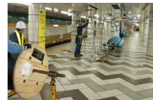
地下鉄駅構内不感知対策工事
