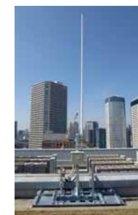
280MHz帯実証実験用アンテナ
