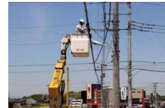
ブロードバンド開通作業
