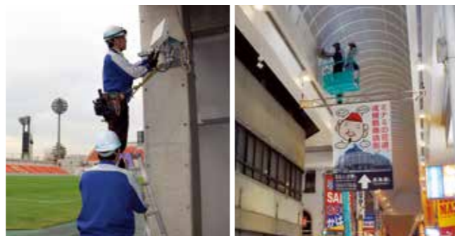
Wi-Fi 環境構築工事
