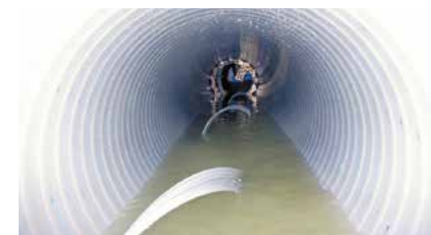
通水しながら工事ができる SPR 工法
