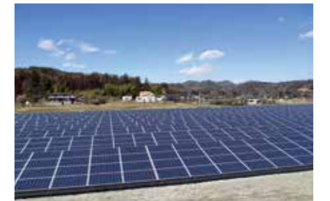
ミライト栃木小野寺太陽光発電所
