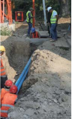
ミャンマーでの光ケーブル敷設工事
