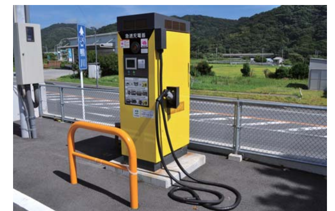
千葉県「道の駅・保田小学校」のEV急速充電器
