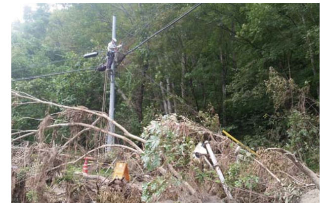
岩手県岩泉町での応急復旧工事
