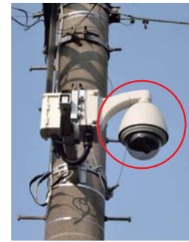
電柱に設置した防犯カメラ
