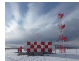
降下経路(高さ)を示すためのグランドバスアンテナ
