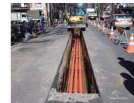
電線類の地中化工事 (電線共同溝工事)
