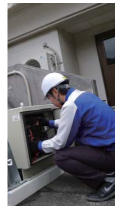
箱根町の実験試験局での水道スマートメーター設置作業
