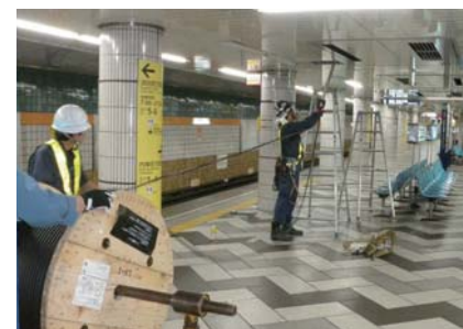
地下鉄駅間不感地対策工事
