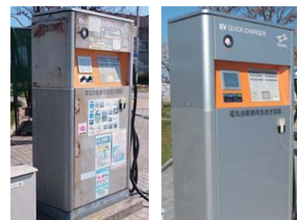
経年劣化でサビが目立つEV急速充電器をラッピングシートにより補修
