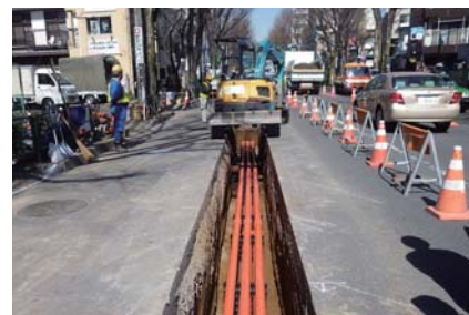
電線類の地中化工事(電線共同溝工事)
