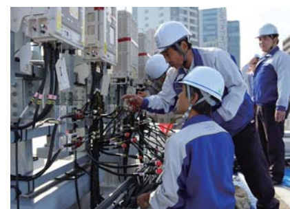
無線基地局建設工事
