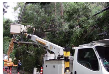
樹木により不通となった架空通信設備の復旧作業 (台風21号)
