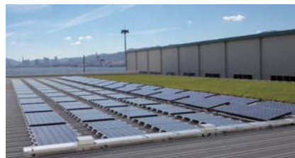
神戸技術センタの太陽光発電設備
