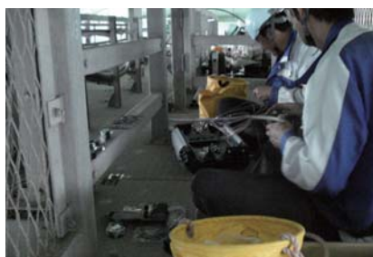
関西国際空港連絡橋損壊に伴う通信設備の復旧作業 (台風21号)
