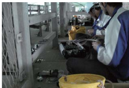
関西国際空港連絡橋損壊に伴う通信設備の復旧作業 (台風21号)
