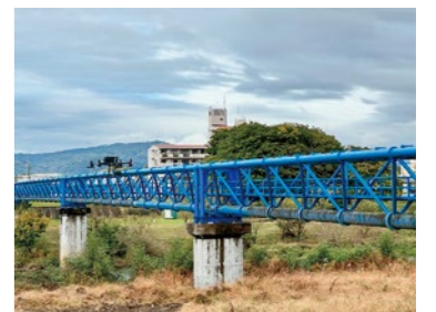
ドローンによる水管橋の点検
