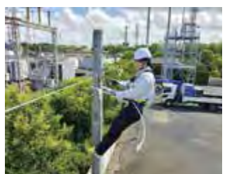
高所作業体感研修
