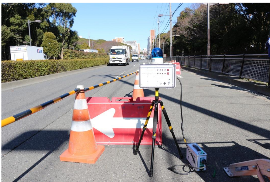
工事現場での設置模様
