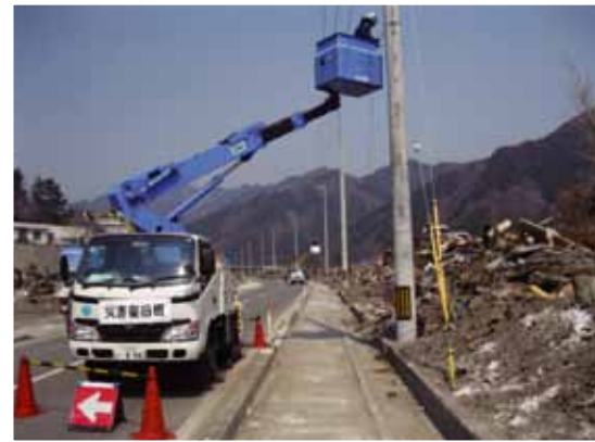
架空ワイヤー架渉作業(岩手県上閉伊郡大槌町・東電通)
