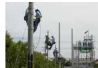
柱上訓練・鉄塔研修
