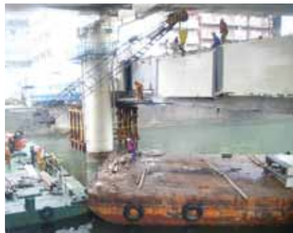
通信専用橋の耐震補強工事
