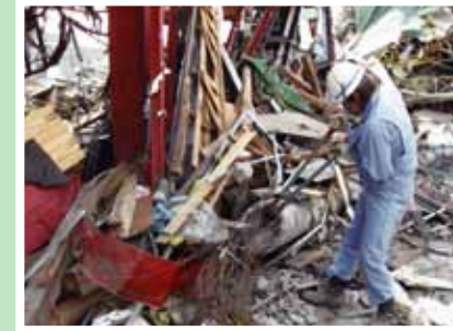
被災した電柱の撤去(岩手県釜石市・東電通)
