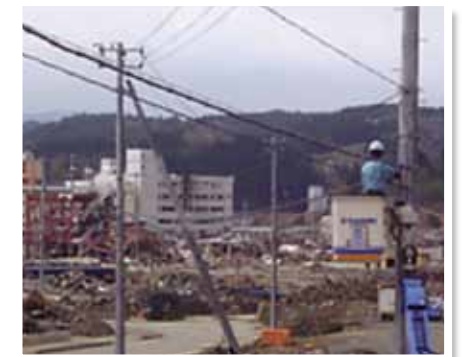
架空ケーブル復旧作業(大明)
