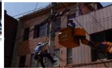
通信ケーブルの応急復旧作業(気仙沼市内・大明)
