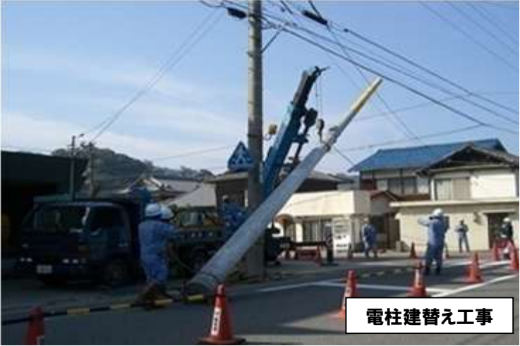
携帯電話無線基地局 併設工事
