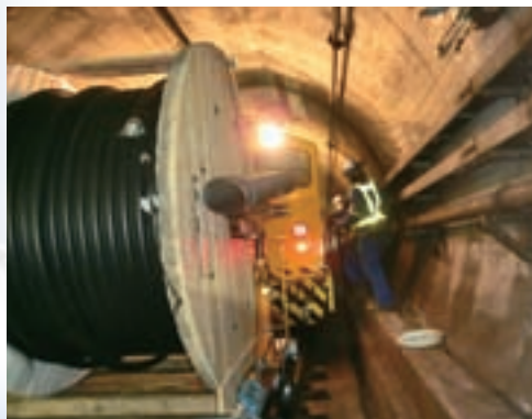
地下鉄駅間電波対策工事の様子
