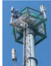
携帯電話 無線基地局建設
