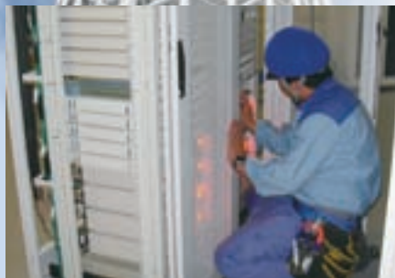
東京スカイツリーでの作業
