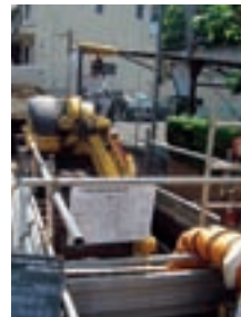
電線共同溝工事
