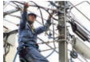
ケーブル架渉工事
