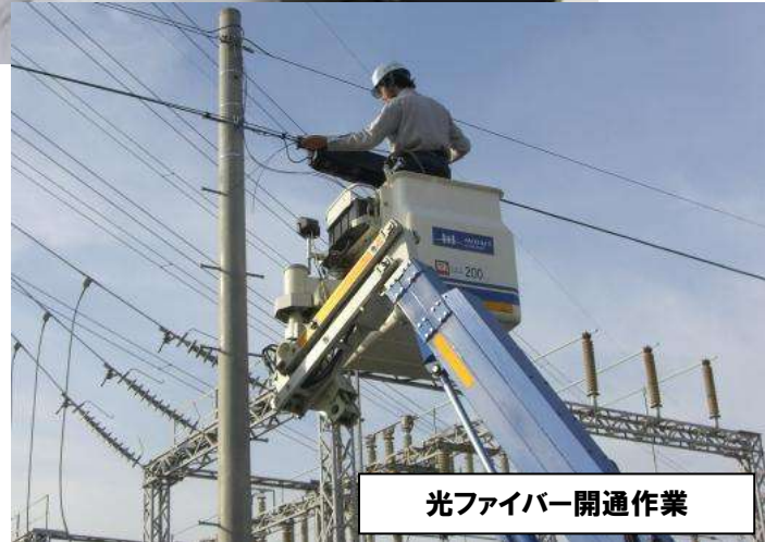
携帯電話無線基地局 併設工事
