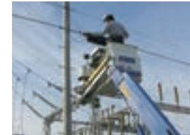
光ファイバー開通工事
