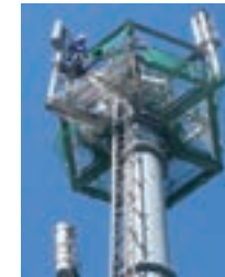
携帯電話無線基地局建設
