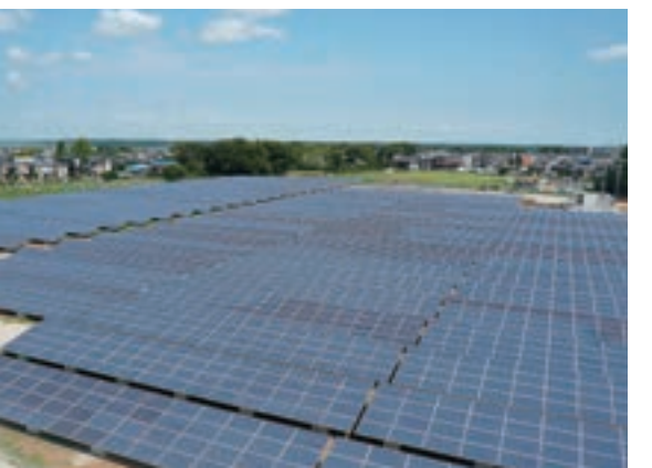
「F佐倉太陽光発電所」建設工事
