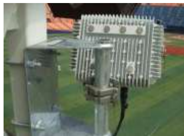
Wi-Fi環境構築工事
