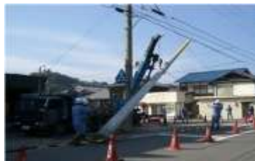
電柱更改工事
