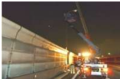
高速道路照明設備改修工事
