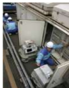
無線基地局調整試験
