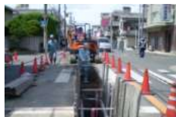
地下管路敷設作業
