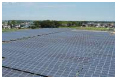
太陽光発電設備建設
