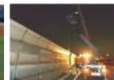
高速道路照明 設備改修工事
