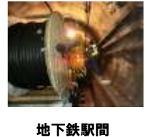
地下鉄駅間 不感地対策工事
