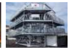
津波避難タワー 建設工事
