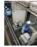
無線基地局調整試験
