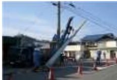
電柱更改工事
