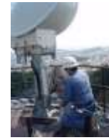
無線基地局保守点検
