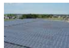
太陽光発電設備建設
