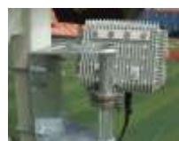
Wi-Fi環境構築工事
