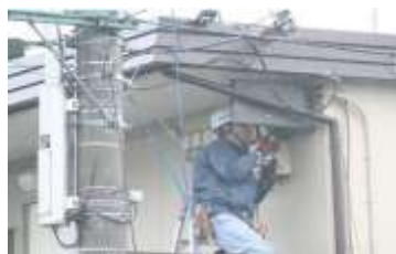
光ケーブル引込作業
