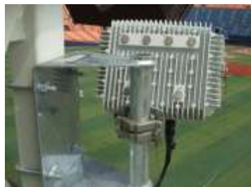
Wi-Fi環境構築工事
