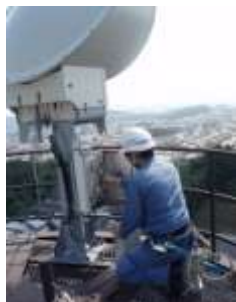
無線基地局保守点検
