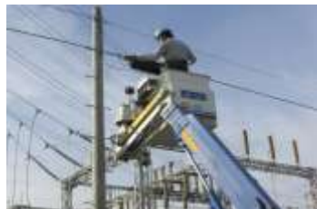
光ファイバー開通作業
