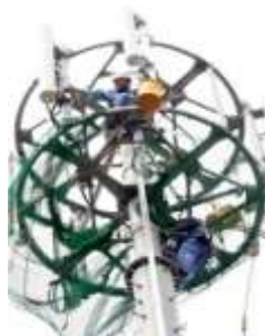
無線基地局併設工事
