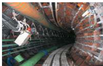
地下設備構築
