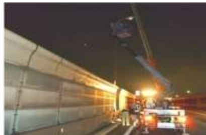
高速道路照明設備改修工事
