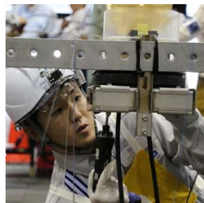
光アクセス設備施工競技 第6位 ミライト 富山 悦宏 選手
