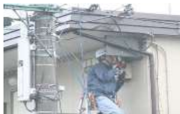
光ケーブル引込作業
