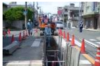
地下管路敷設作業
