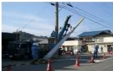
電柱更改工事
