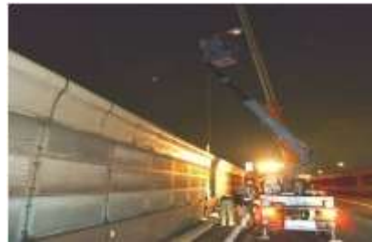
高速道路照明設備改修工事
