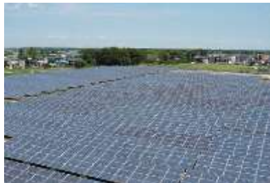
太陽光発電設備建設
