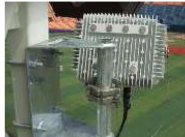
Wi-Fi環境構築工事
