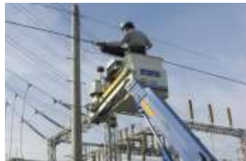
光ファイバー開通作業
