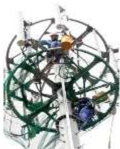
無線基地局併設工事
