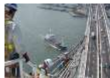
高速道路照明 設備改修工事
