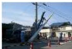
電柱更改工事
