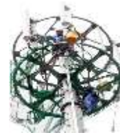
無線基地局併設工事
