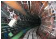
地下設備構築
