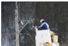
光ケーブル接続作業
