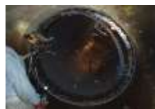
老朽下水管更生作業 （SPR工法）
