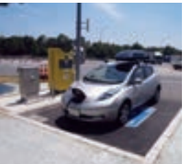
EV充電器設置
