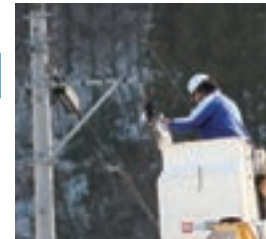
光ケーブル接続作業
