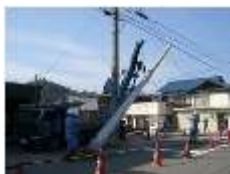
電柱更改工事
