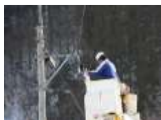
光ケーブル接続作業
