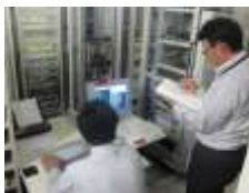
交換機プログラム更新作業
