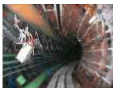
地下設備構築
