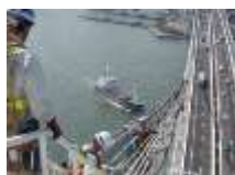
高速道路照明 設備改修工事
