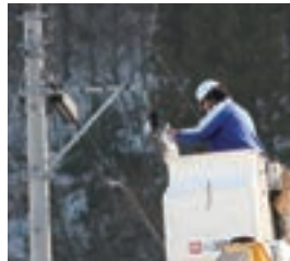
光ケーブル接続作業
