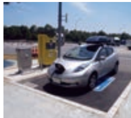
EV充電器設置
