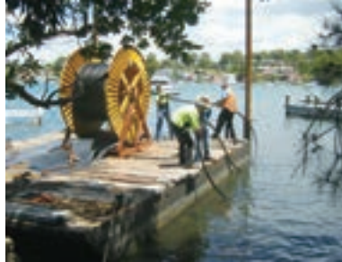
海底ケーブル敷設作業
