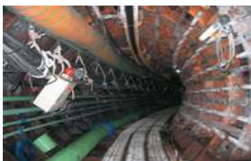
地下設備構築
