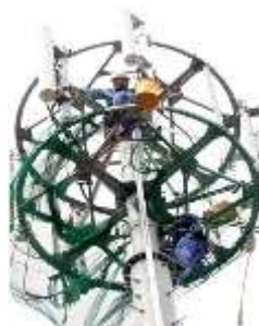
無線基地局併設工事
