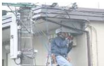
光ケーブル引込作業
