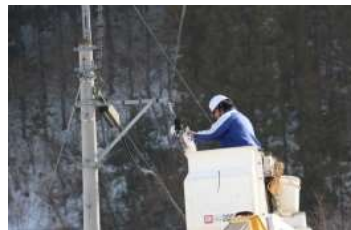
光ケーブル接続作業
