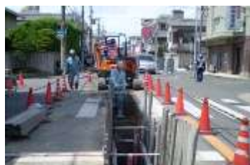
地下管路敷設作業
