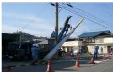
電柱更改工事
