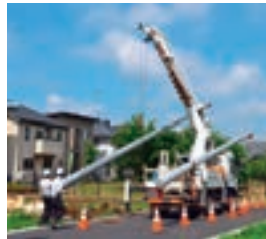
電柱建柱工事
