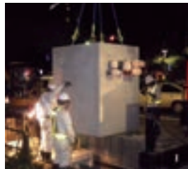
電線類地中化工事
