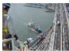
高速道路照明 設備改修工事
