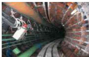
地下設備構築
