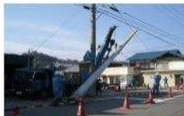
電柱更改工事
