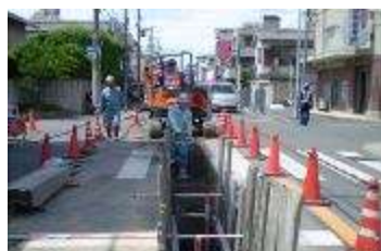
地下管路敷設作業
