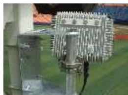
Wi-Fi環境構築工事
