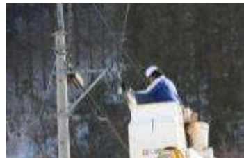
光ケーブル接続作業
