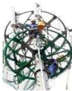
無線基地局併設工事
