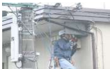
光ケーブル引込作業
