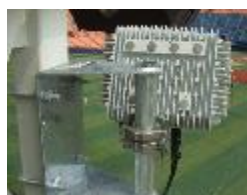
Wi-Fi環境構築工事
