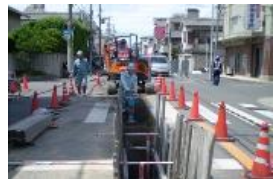
地下管路敷設作業
