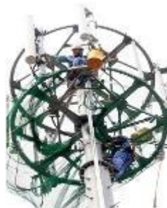
無線基地局併設工事
