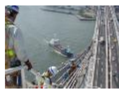
高速道路照明 設備改修工事
