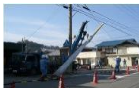
電柱更改工事
