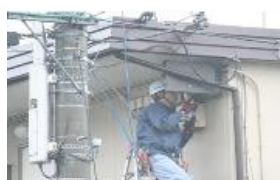
光ケーブル引込作業
