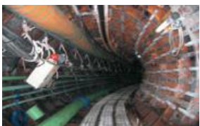
地下設備構築
