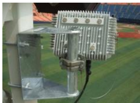
Wi-Fi設置工事(野球場)
