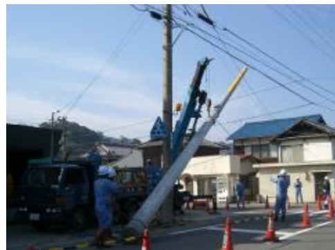
電柱更改工事
