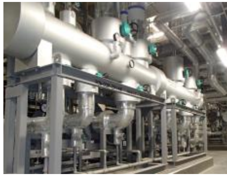
空調設備工事
