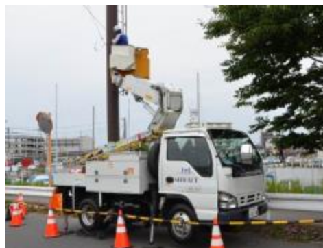
ケーブル接続工事
