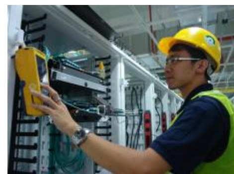
LAN配線工事(Lantrovision)
