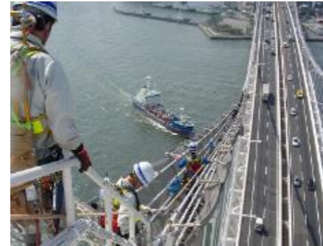
照明設備改修工事(高速道路)
