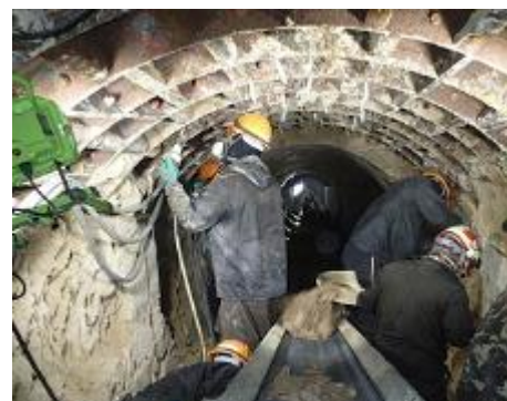
土木工事(とう道)
