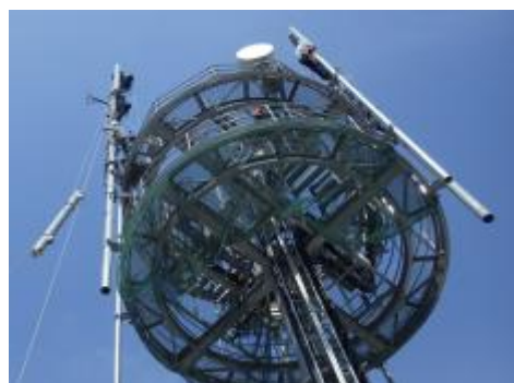
無線基地局建設工事
