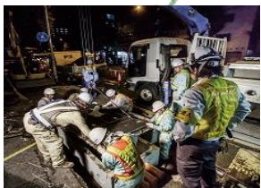
電線地中化工事
