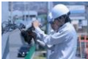
光ネットワークの開通工事
