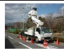
LED設置工事
