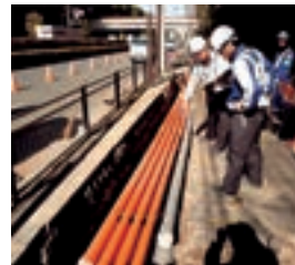
電線地中化工事
