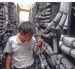
LAN配線工事(Lantrovision)
