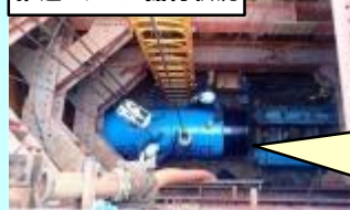
推進マシン据付状況
