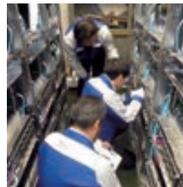
LAN・PBX工事
