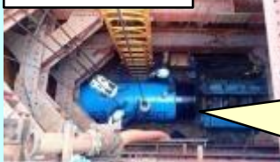
推進マシン据付状況
