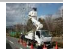
LED設置工事
