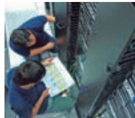
LAN配線工事(Lantrovision)
