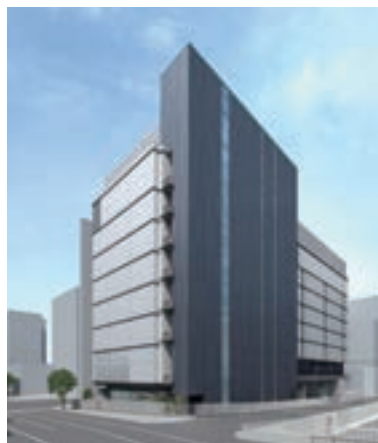
大阪第1データセンター（イメージ）
