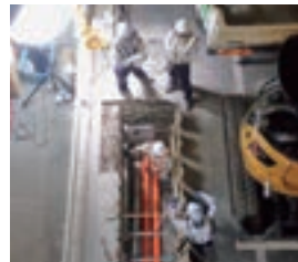
電線地中化工事
