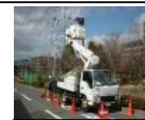
LED設置工事
