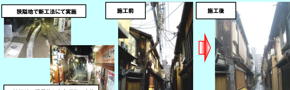
狹隘地で重量物を人力運搬で実施
