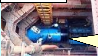
推進マシン据付状況
