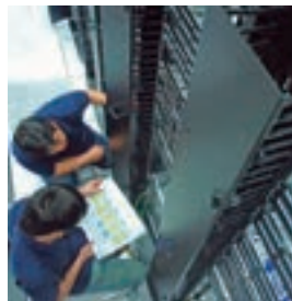
LAN配線工事(Lantrovision)
