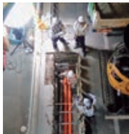
電線地中化工事
