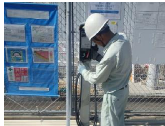
設置後の通信・動作確認
