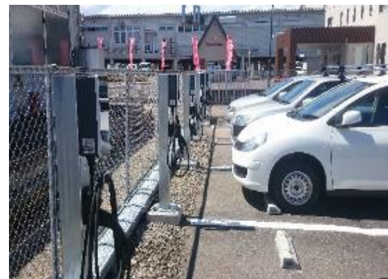
設置後の状況
