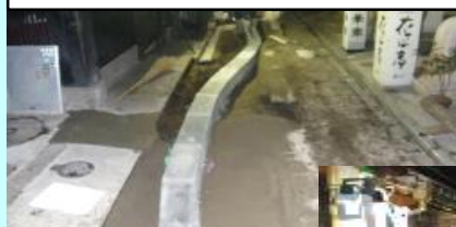
狹隘地で新工法にて実施
