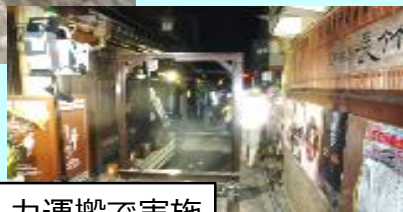
狹隘地で重量物を人力運搬で実施
