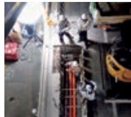
電線地中化工事
