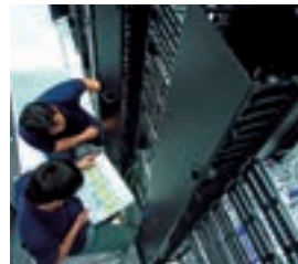
LAN配線工事(Lantrovision)
