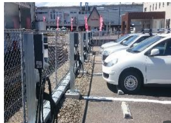
設置後の状況
