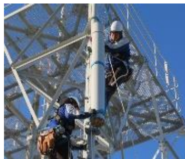
アンテナ設置
