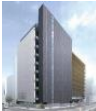
大阪第1データセンター
