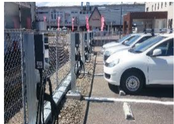
設置後の状況
