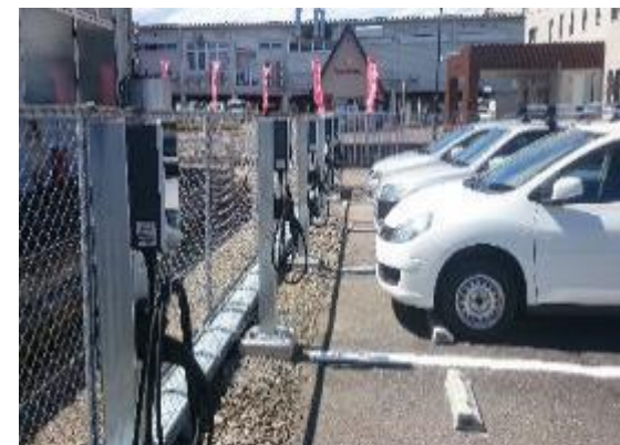
設置後の状況
