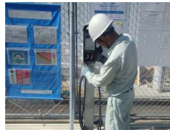
設置後の通信・動作確認
