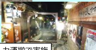
狹隘地で重量物を人力運搬で実施
