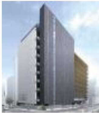
大阪第1データセンター
