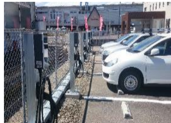
設置後の状況
