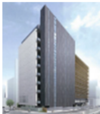
大阪第1データセンター
