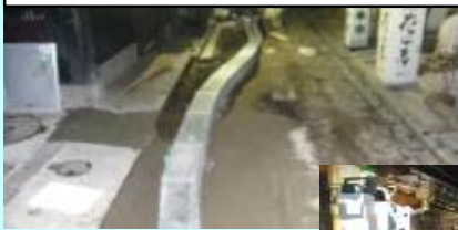
狭隘地で新工法にて実施
