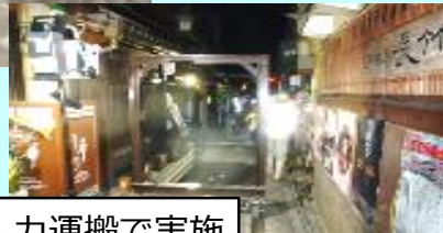
狭隘地で重量物を人力運搬で実施
