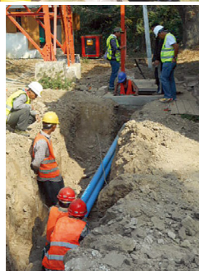
ミャンマーにおける 通信管路敷設工事
