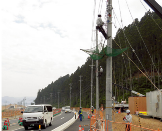
ケーブル架設作業
