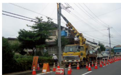
民有地での電柱建替工事
