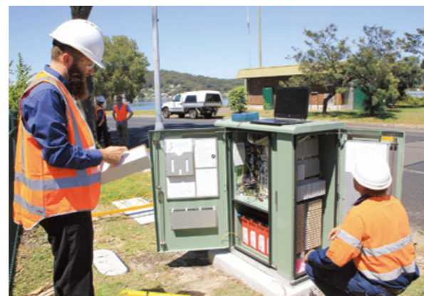
オーストラリアにおける 光回線接続工事
