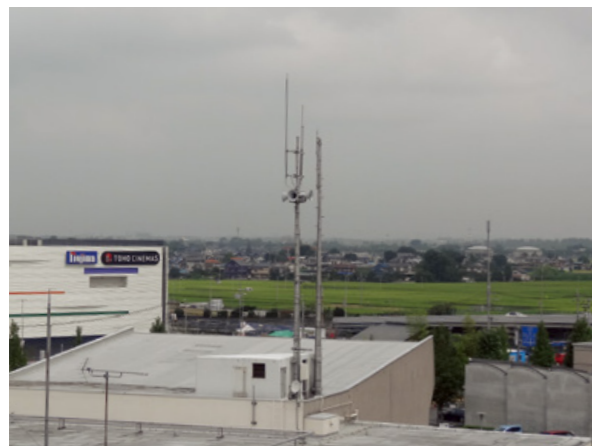
防災行政無線アンテナ
