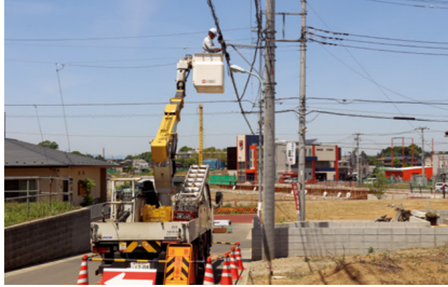
ブロードバンド開通作業
