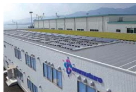
太陽電池パネルと屋上緑化
