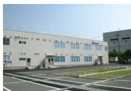
緑化された駐車場
