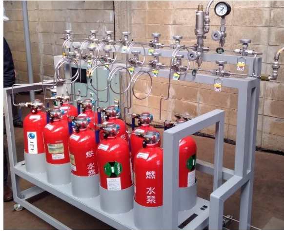
国内初 29.4MPa で高圧水素容器 10 本同時に充填している様子
