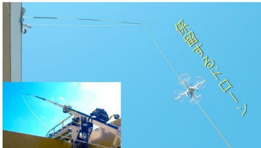
ラインドローンシステム (西武建設株式会社)
