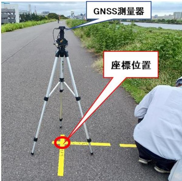
GNSS 測量器を使用し座標地点に墨出し
